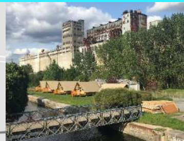
Pied du Silo no.5
