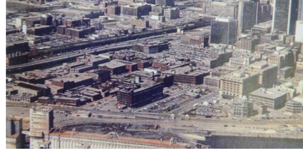
État initial du faubourg des Recollets, dans les années 1990 (source: Archives du service de mise en valeur de Montréal)
